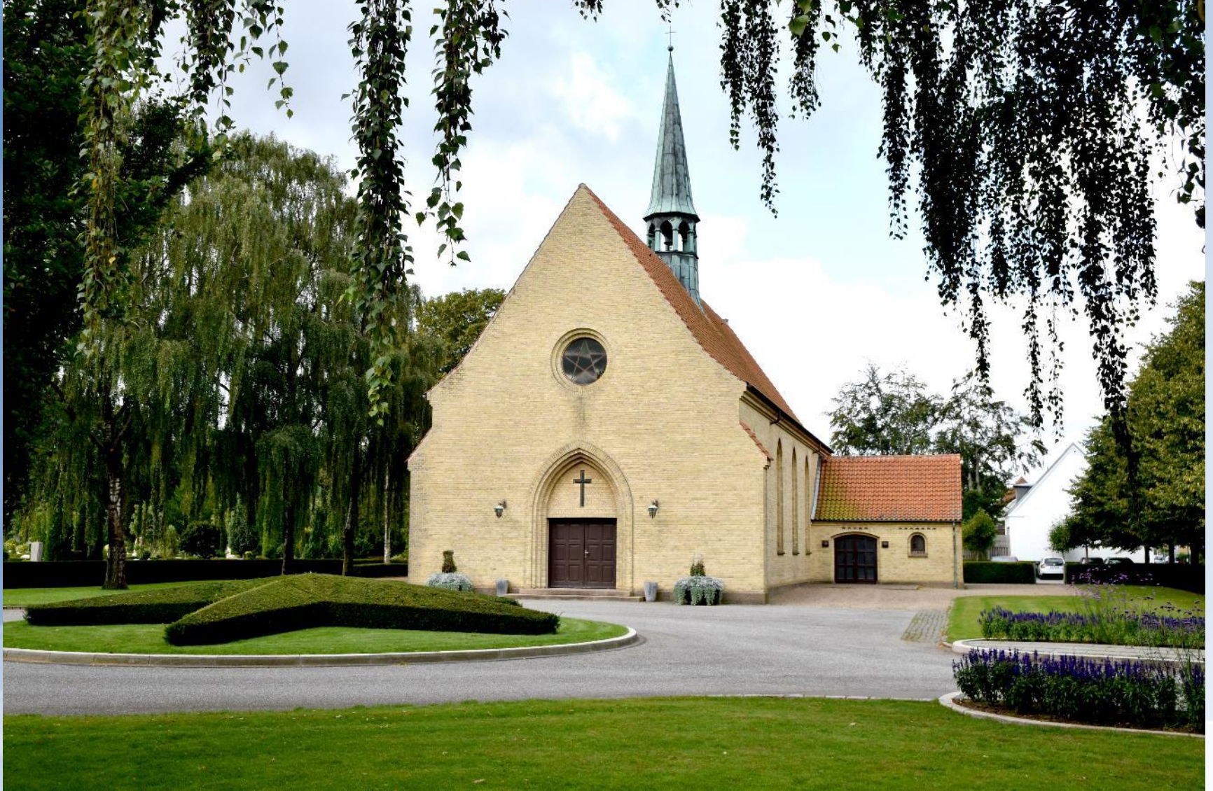
Vestre Kapel og forplads – reovering og etablering
